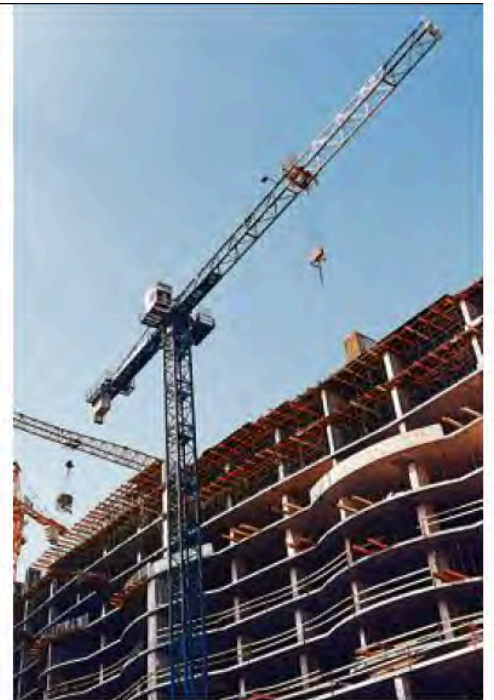
Disposer d'un logement récemment construit est un atout. Économe en énergie, il sera aussi exempt de gros travaux dans les dix ans à venir. Photo Shutterstock
